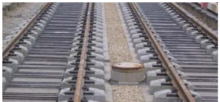
Ausgelegter und ausgerichteter Gleisrost
