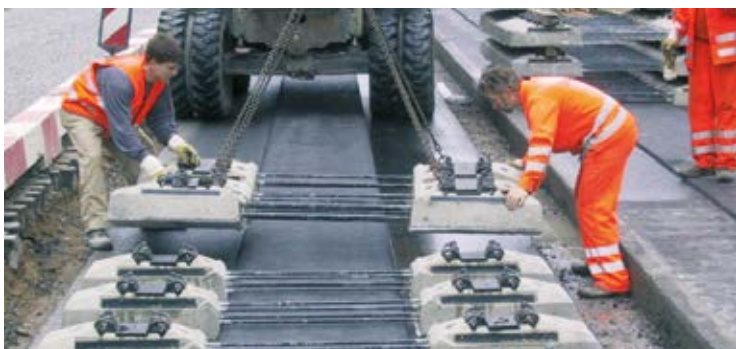
Auslegen der Schwellen auf fertig gestellter Asphalttragschicht
